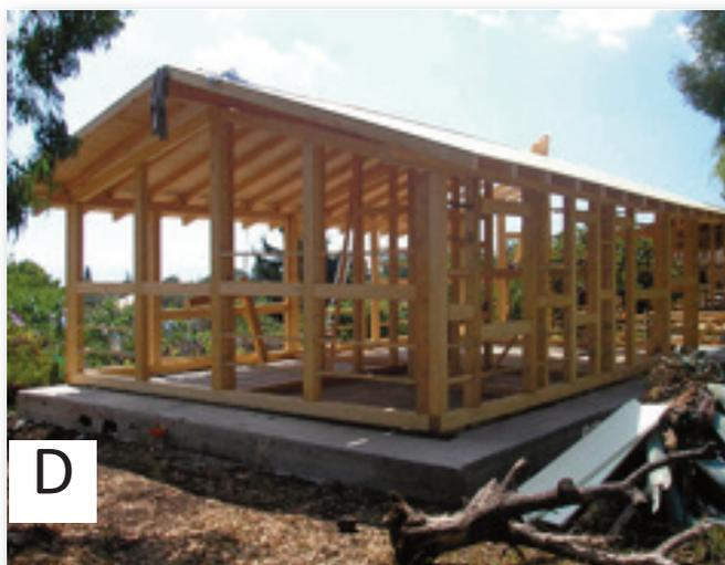
**Fig X.3. Esempi di struttura portante: a) muratura, b) cemento armato , c) acciaio, d) legno**
