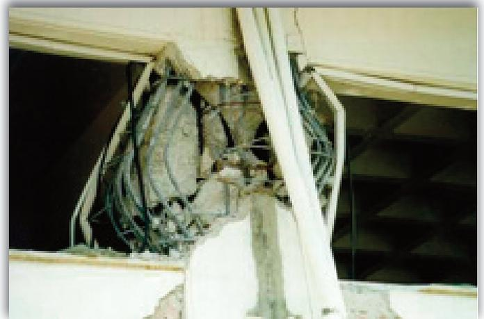
**Fig.X.6 Esempio di danno localizzato in una struttura in cemento armato (grave danno alla testa di un pilastro a causa della presenza delle tamponature di altezza limitata delle per la realizzazione di finestre a nastro).**
